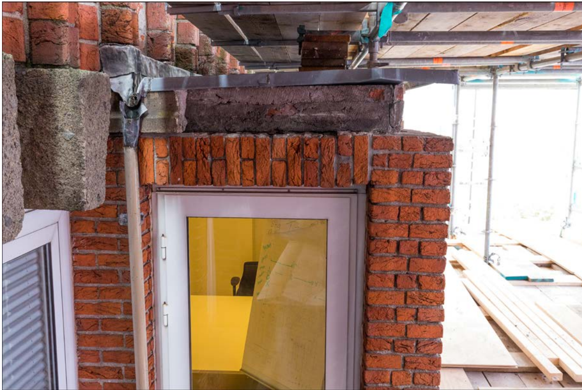
LOOD- EN ZINKWERK EN METSELWERK PENANT BOVEN DE DEUREN VAN HET BALKON VERNIEUWD:
