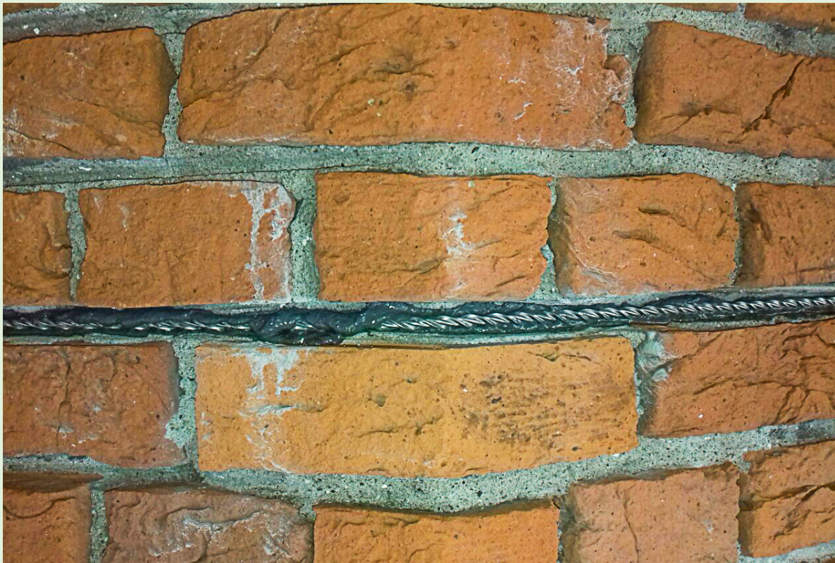
UITVOEREN METSELWERK REPARATIES:
