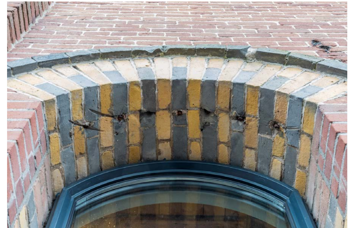
IJzeren traliewerk is verwijderd, de uiteinden zijn in het metselwerk achtergebleven
