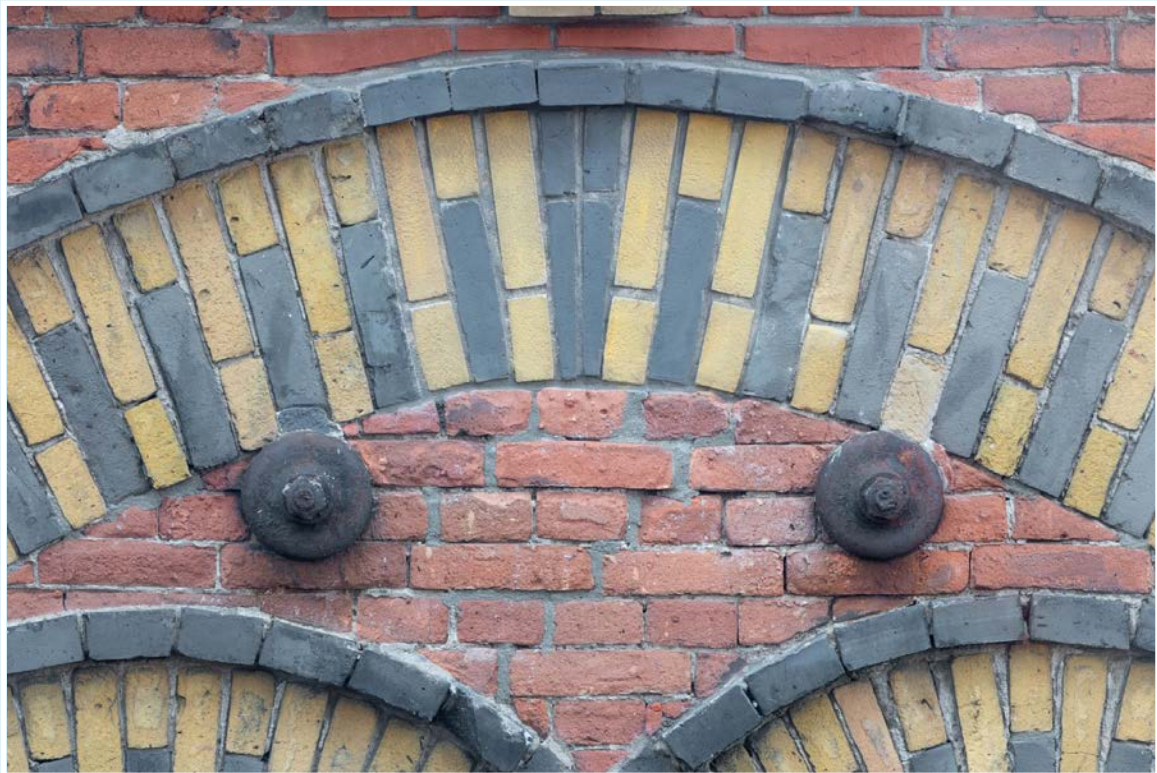
Dezelfde plek na reparatie en patineren zodat het bestaand oud metselwerk lijkt
