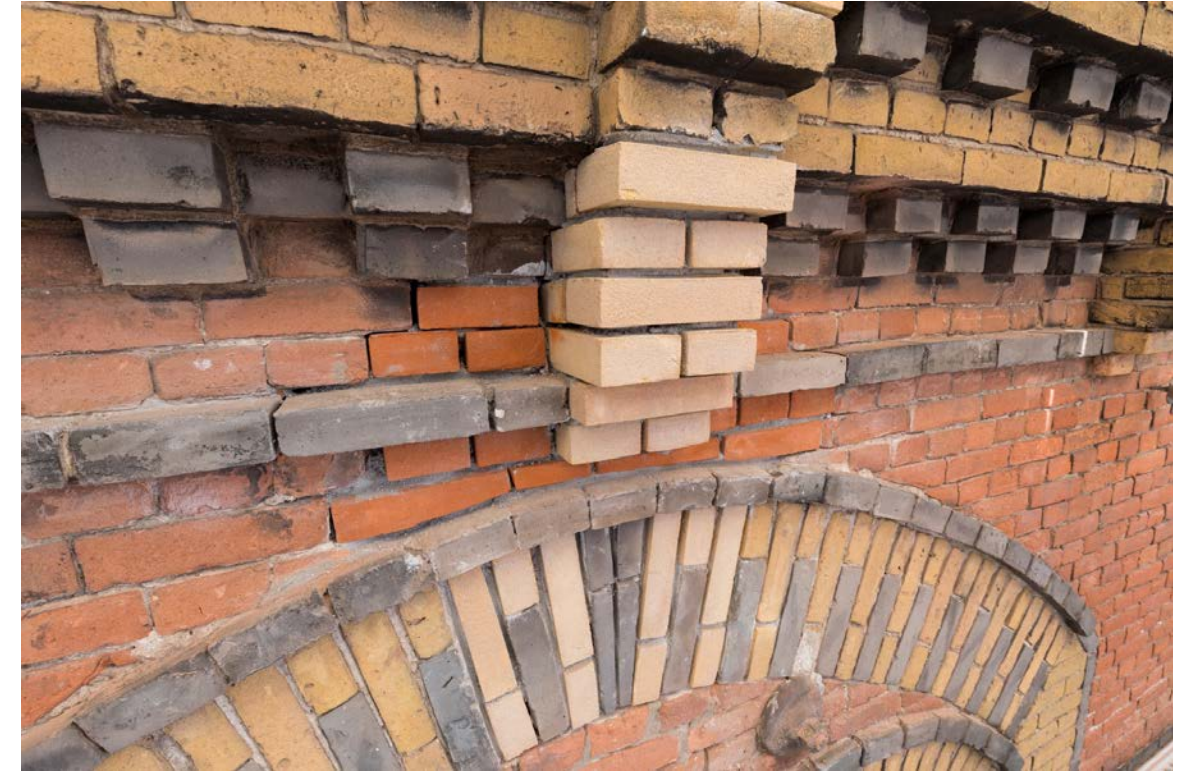
Vervangen metselwerk dat wij later patineren om het te laten matchen met het oude metselwerk
