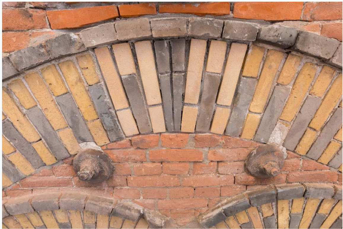
Vervangen metselwerk dat we later patineren zodat het verouderd lijkt
